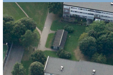
Figur 3. Det finns byggnader med cykelboxar insprängda i bebyggelsen.
