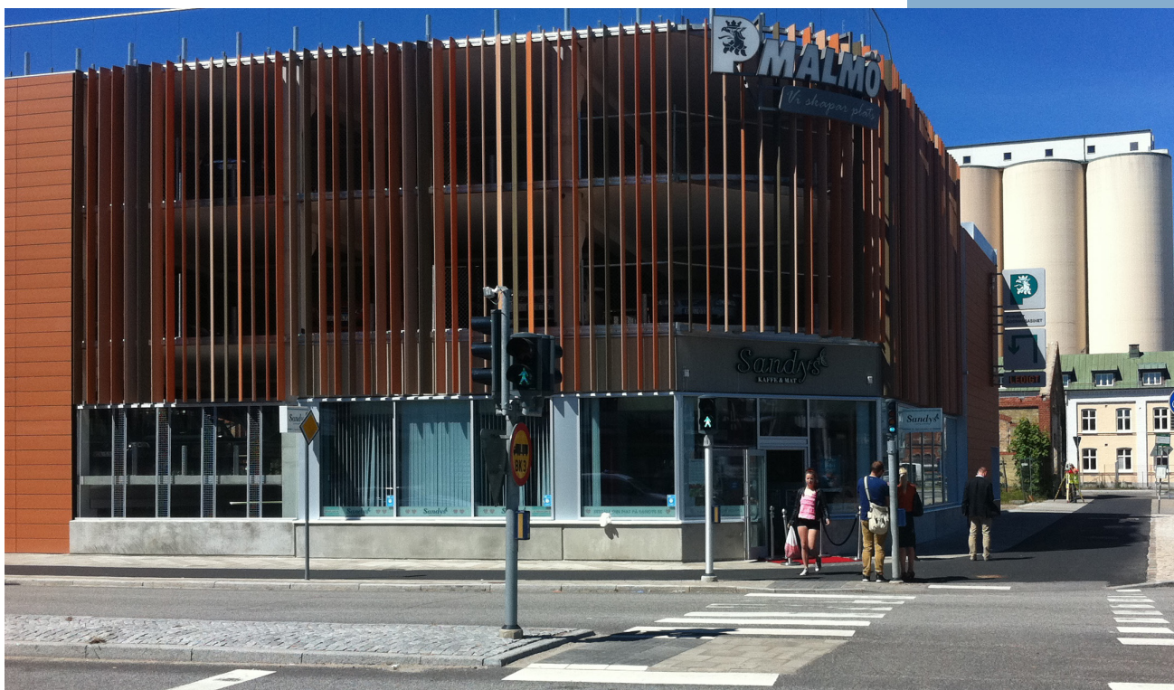
Figur 28. P-huset Godsmagasinet i Malmö. I bottenplan finns ett Café och parkeringshuset har stora glasade partier och lameller som släpper in ljus.
