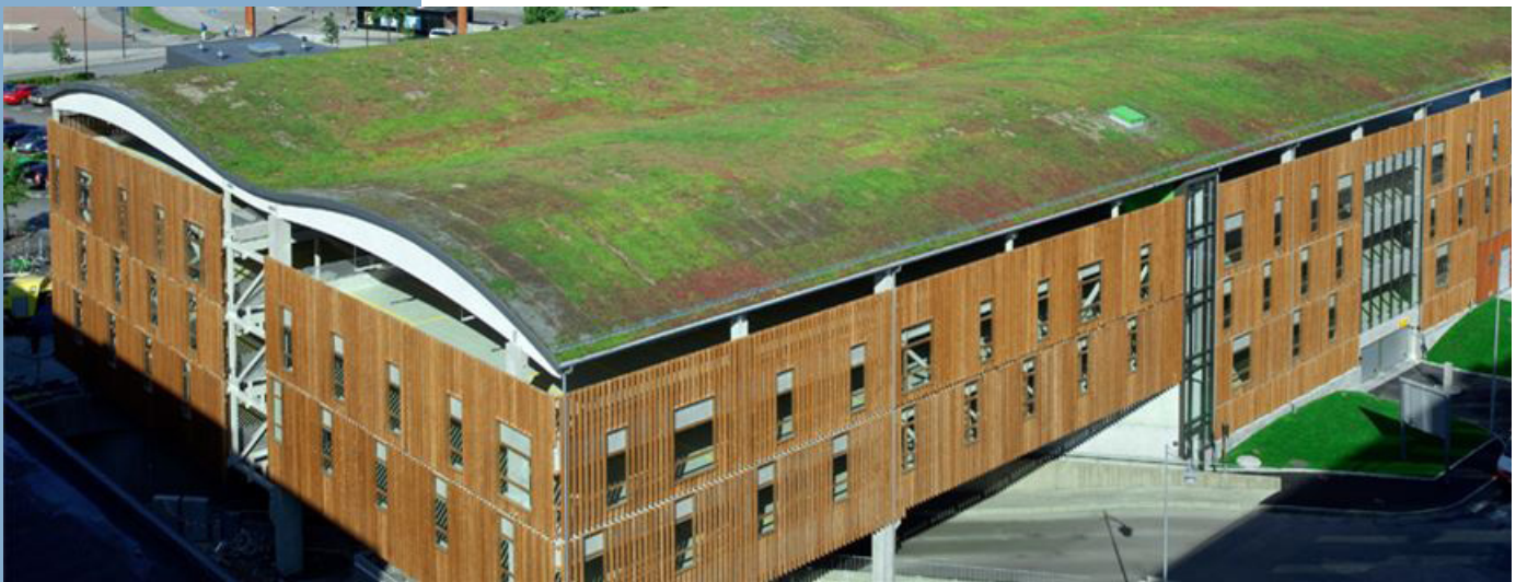
Figur 29. P-huset Lindholmen, Norra Älvstranden i Göteborg. I bottenplan finns butikslokaler. P-husets fasad består i stora delar av en träspalje som släpper in ljus
