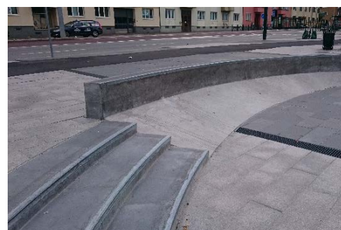
Exempel på olika dagvattenlösningar ovan mark som kan integreras i utformningen av t ex en torgyta.
