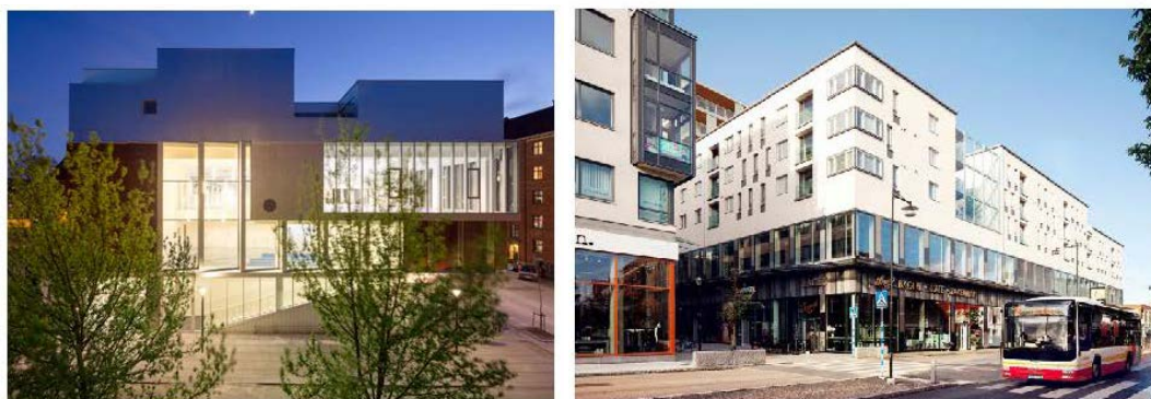
Exempel på hur bostadsvåningarna utformningsmässigt kan skilja sig från ytor med vårdcentral eller service. Foto: White arkitekter
