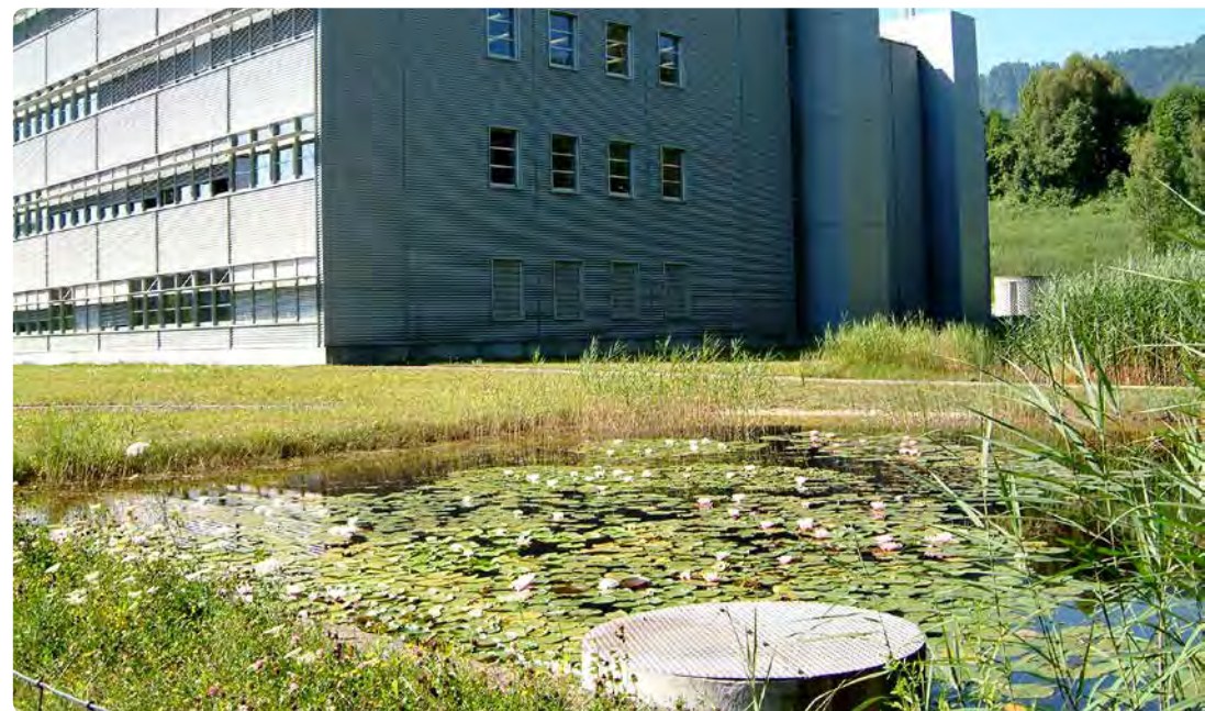
Dagvattendamm vid en industribyggnad i Zürich.
