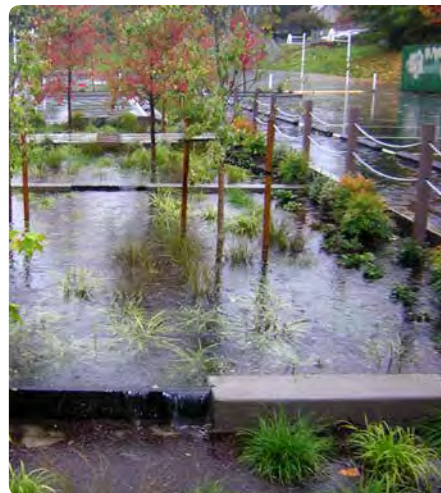
Regnträdgård (dagvattenbiofilter)fördröjer och renar dagvatten. Foto: Kevin R. Perry, City of Portland, USA.
