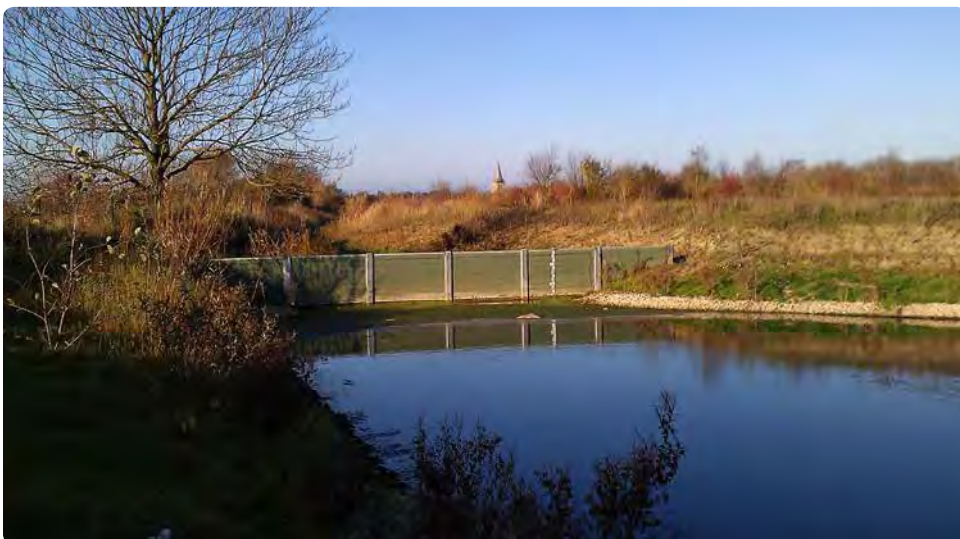
Oljeskärm i en sedimentations- och fördröjningsdam är ett sätt att avskilja olja och flytande skräp. Foto: Sofia Hedström
