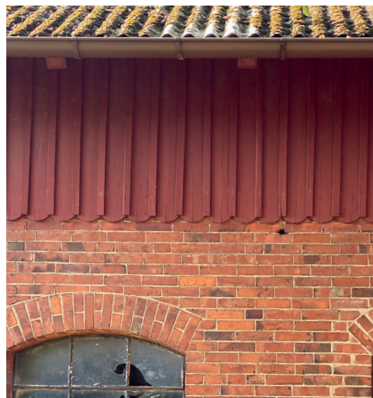
Teglad sockel med röd lockpanel
