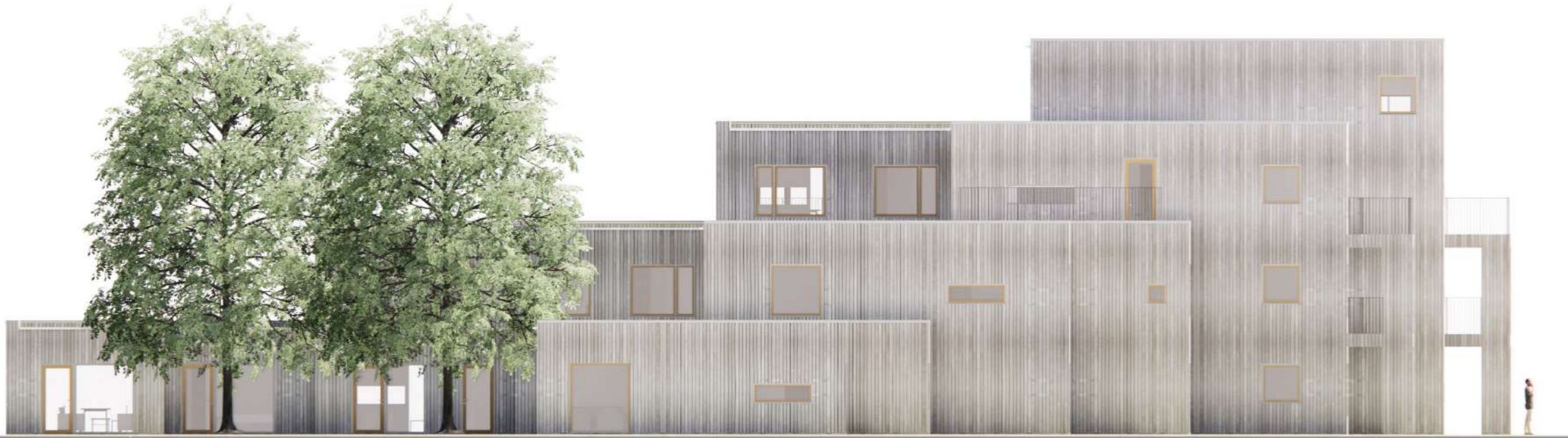
Hus 3 fasad norr
