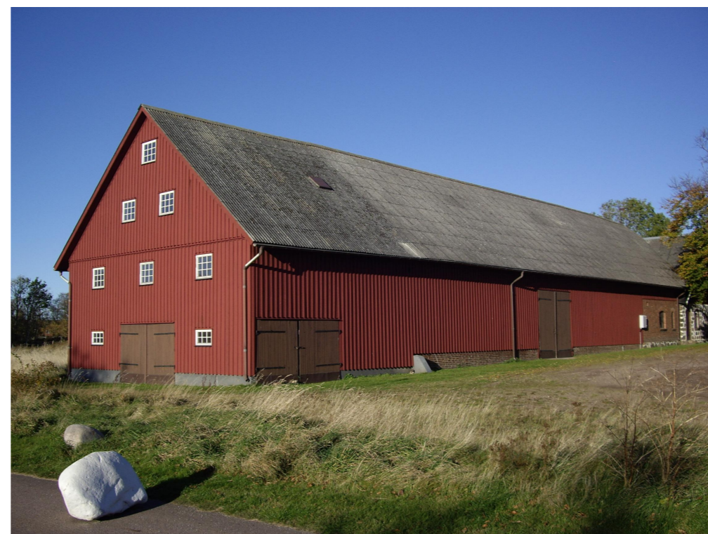
Foto från Laröd. Hagar med gårdsbyggnad i trä.
