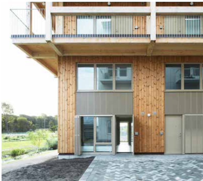
Fasad och etagelägenhet markplan Kv Initiativet
