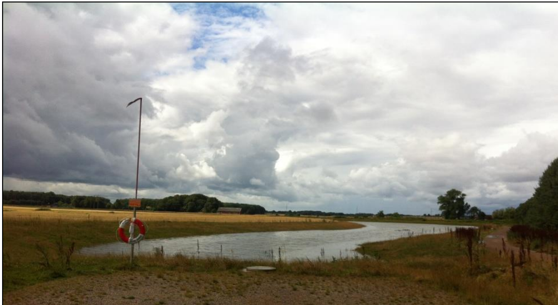
Dagvattenmagasinet vid Väla Gård är utformat som en torr yta och står i normalfallet nästan helt utan vatten. När det regnar fylls magasinet på och hjälper till att fördröja flöden. Bilden är tagen vid det kraftiga regntillfället i augusti 2013. Foto Maria Karlsson Green
