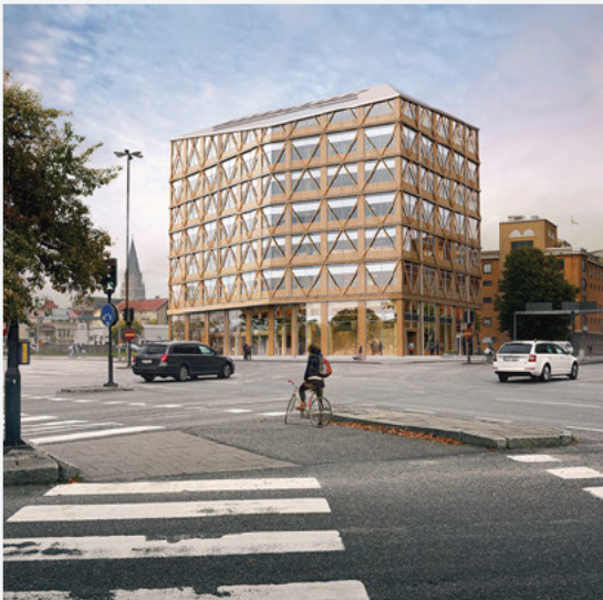
Castellum bygger med trästomme i Örebro. Genom att använda trä blir utsläppen ca 40 % lägre i jämförelse med en traditionell konstruktion.
