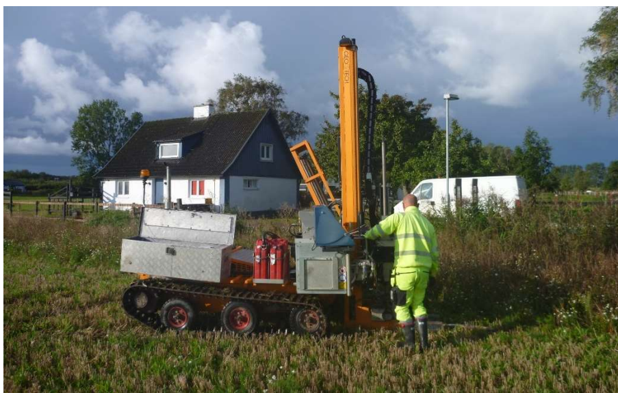
Figur 2. Provtagning med skruvborr monterad på bandvagn.
