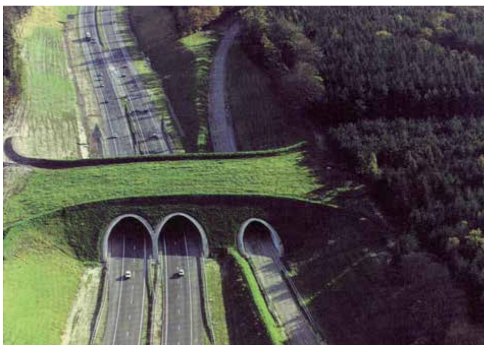
Våra större vägar är kraftiga barriärer i landskapet för både människor och djur. Bilden visar ett exempel på ekodukt från Tyskland.
