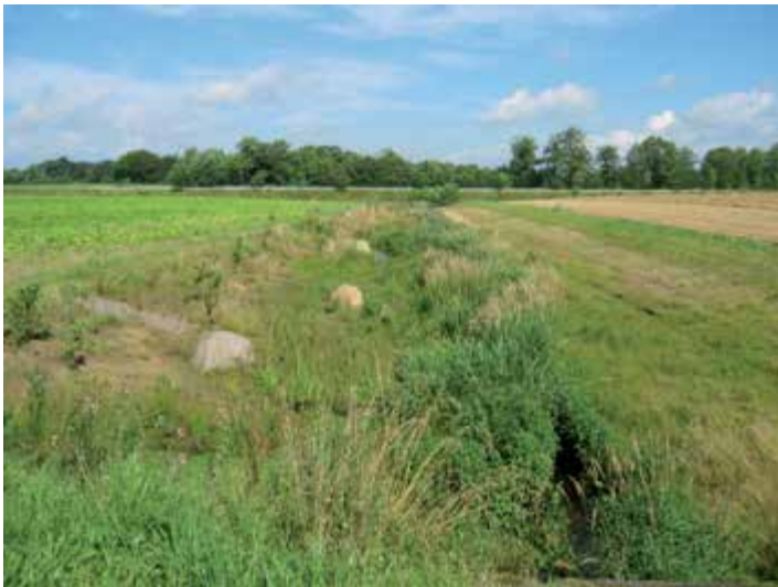
När dikeskanterna flackas av, får vattnet mer plats. Här ser man Lussebäcken söder om Fältarpsvägen före och efter ett regn. Bäckan rann tidigare i ett smalt dike utan någon strandzon, se bild nedan.
