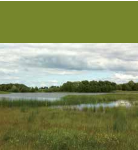
Anlagd våtmark vid Allerumsskogen. Här omvandlas näringen i vattnet till ofarlig kvävgas och biomassa.
