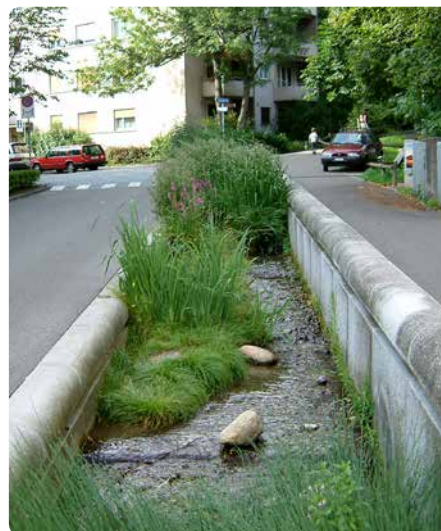
Vägdagvattnet kan också renas och fördröjas i en kanal, som vid denna gata i Zürich.
