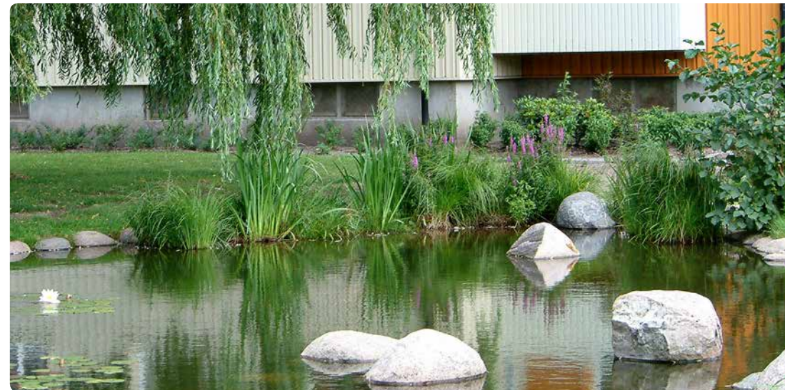
Dagvattendamm på gård vid flerbostadshus i Malmö.
