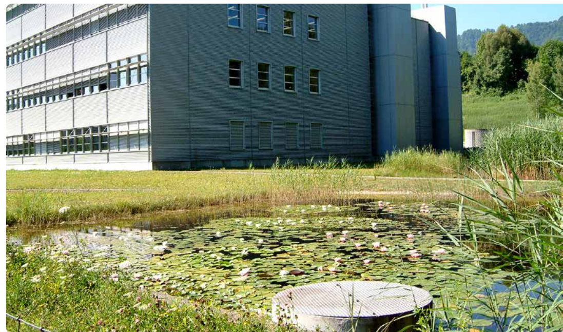
Dagvattendamm vid en industribyggnad i Zürich.
