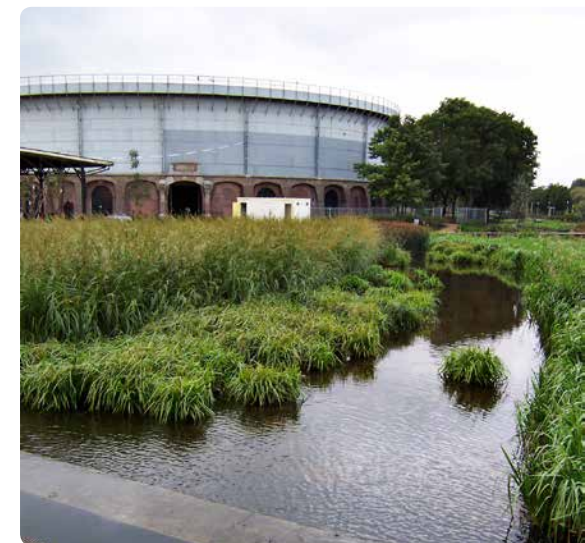
Vegetation i dagvattendammar leder till bättre rening av dagvattnet bl a genom att vattnet filtreras och att växterna ger stora ytor att leva på för mikroorganismer, som bryter ner föroreningar. Foto: Siv Degerman
