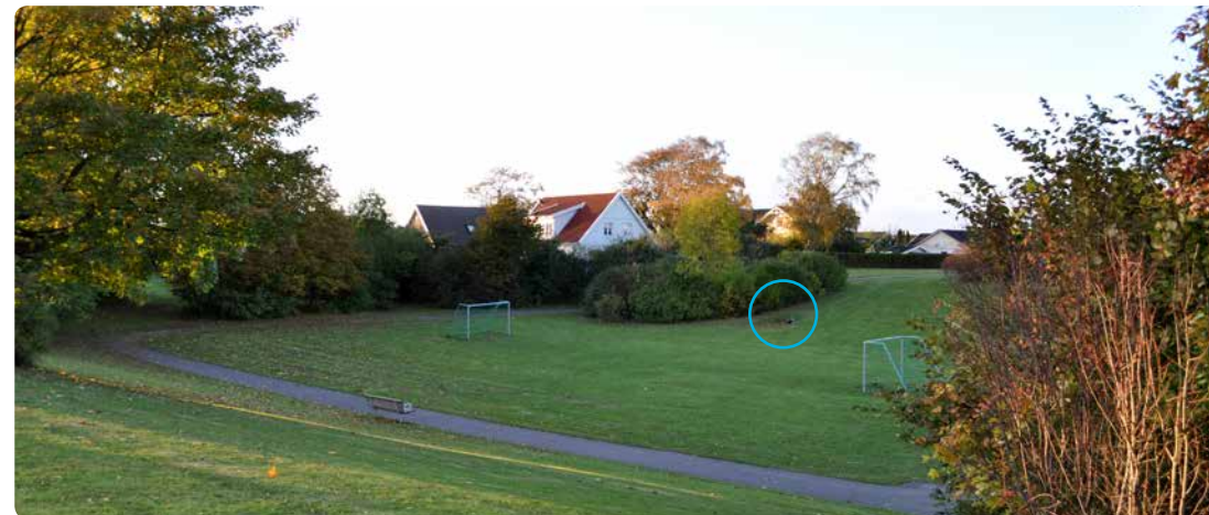
En park i Lomma används både som översvämningsyta vid stora regn och som fotbollsplan. Bräddavlopp från ledning till översvämningsyta är inringad.
