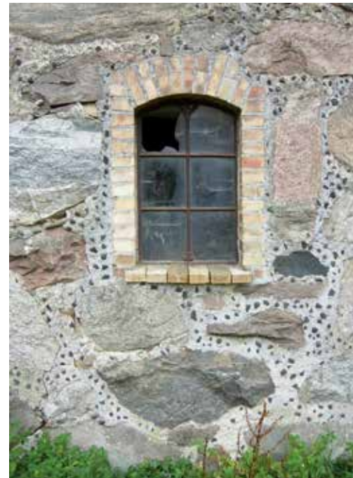
Äldre fönster kan renoveras för att få bättre energivärden, Ljusekulla gård.
