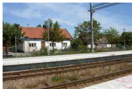
Gatusträckning längs järnvägen i Påarp.
