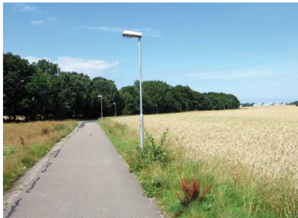
Bild 41 Belysning längs cykelväg
