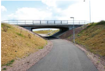
Bild 1 Tunnel under Kullavägen
