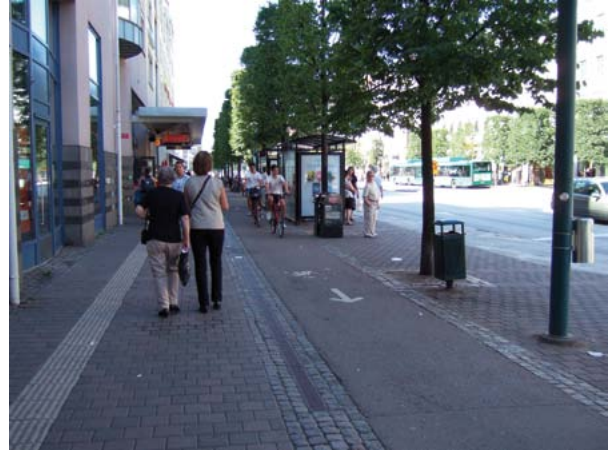
Bild 31 Gång- och cykelbana separeras med olika beläggning
