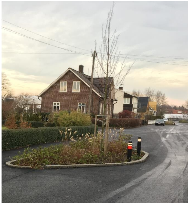
Figur 30. En av flera raingardens på lokalgata i Munka Ljungby. Anläggningen har en nersänkt plantering med filtermaterial. Foto Graciela Nilsson NSVA.
