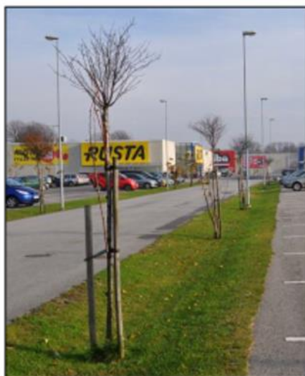
Figur 24. Två exempel på svackdiken. Kupolbrunnen placeras högre än marknivå eftersom dagvattnet i första hand ska infiltrera genom gräs och makadam. Foto Lars-Erik Widarsson.
