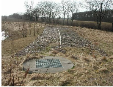
Figur 11. Planerad ytavrinningsbrädd.
