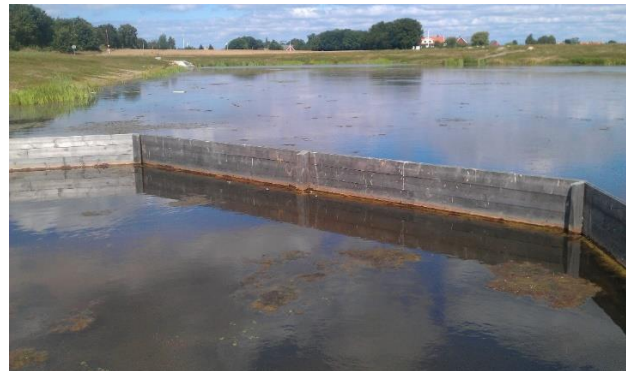
Figur 13. Oljeskärmar vid inlopp till magasin. Vattnet rinner under skärmen och eventuell olja stannar på ytan. Oljan avlägsnas vid tillsyn.
