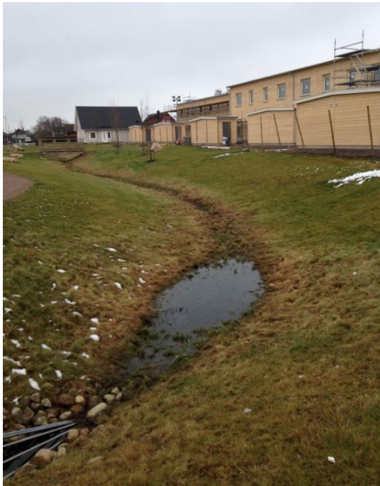
Figur 19. Avrinningsstråk där vattnet kommer direkt från utkastare och från dagvattenledning. Dagvattnet leds vidare till damm. Musserongatan Gantofta. Vintersäsong och två år gammalt då fotot togs.
