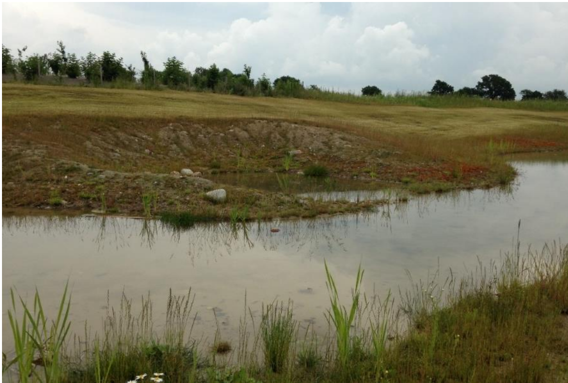
Figur 5. Grund "groddamm" i kanten av dagvattendammen för att gynna biologisk mångfald. Tegeldammen, Påarp ett år efter anläggning.
