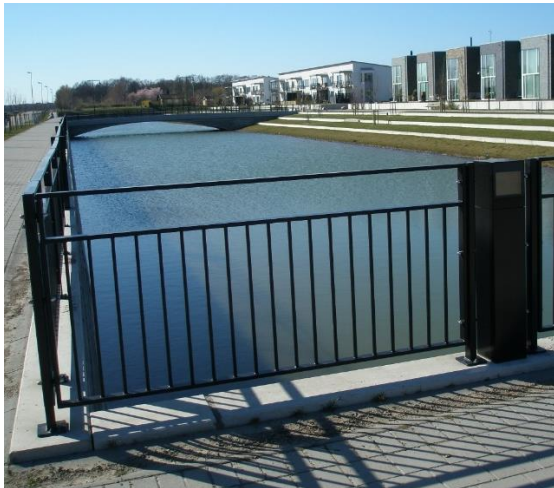
Figur 15. Dammar hägnas inte in utan projekteras med flacka, fasta slänter. Vid brant kajkant ska dock stabilt räcke finnas. Foto till vänster på räcke vid Senderödsvägen Helsingborg. I högra bilden från samma damm har flytande våtmarker anlagts och undervattensväxter har etablerat sig vilket är bra för reningen. Foton Lars-Erik Widarsson och Sofia Augustsson.
