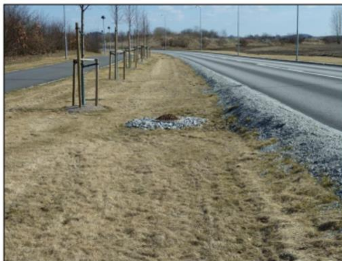
Figur 24. Två exempel på svackdiken. Kupolbrunnen placeras högre än marknivå eftersom dagvattnet i första hand ska infiltrera genom gräs och makadam. Foto Lars-Erik Widarsson.
