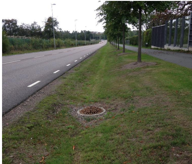
Figur 27. Exempel på vägavvattning till dike. Fälbornavägen Helsingborg. Foto Sofia Augustsson.
