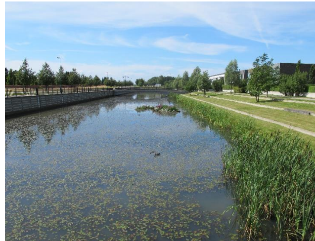
Figur 15. Dammar hägnas inte in utan projekteras med flacka, fasta slänter. Vid brant kajkant ska dock stabilt räcke finnas. Foto till vänster på räcke vid Senderödsvägen Helsingborg. I högra bilden från samma damm har flytande våtmarker anlagts och undervattensväxter har etablerat sig vilket är bra för reningen. Foton Lars-Erik Widarsson och Sofia Augustsson.
