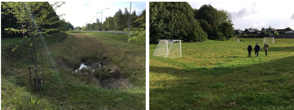
Figur 21. Planerade översvämningssytor i Vellinge där dagvatten från ledningsnätet leds ut via munkbrunn vid kraftigt regn. Liknande ytor finns i Raus Helsingborg och byggs i Bjuv. Foto Hanna Palm Johansson NSVA. Se också foton på lekplats och skolgård i dagvattenpolicyn.
