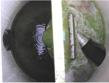
Figur 10. Ingjuten flödesregulator
