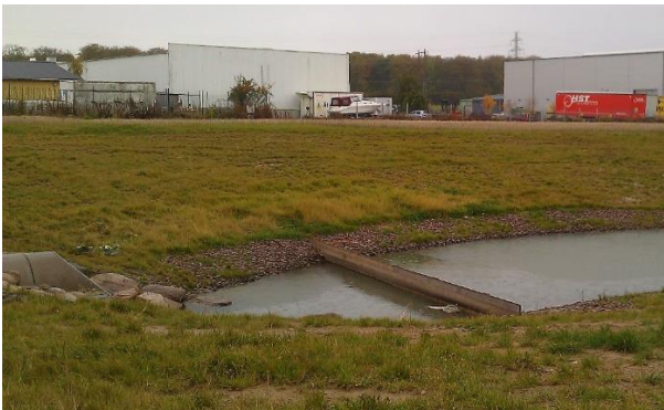
Figur 13. Oljeskärmar vid inlopp till magasin. Vattnet rinner under skärmen och eventuell olja stannar på ytan. Oljan avlägsnas vid tillsyn.
