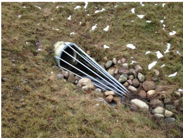
Figur 8. Strutformat galler i trumöga i utlopp från dike till ledning. Gallrets stora area motverkar igensättning av löv etc. Se även bilaga 8. Foto från Musserongatan, Gantofta.
