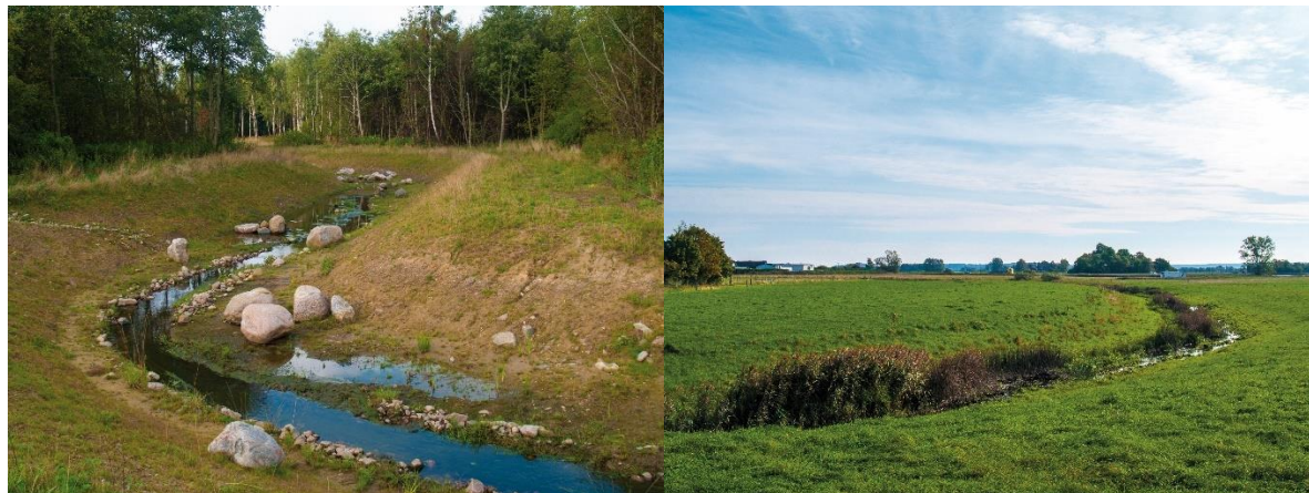
Figur 26. Tvåstegsdiken anlagda av Helsingborgs stad i Pålsjö och Hasslarp. I det vänstra diket avleds dagvatten. Foton från "Anlagda våtmarker" (Oscar Hassby, Helsingborgs stad 2015).
