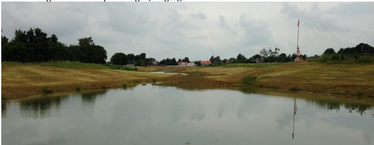
Figur 6. Varierad slänthlutning vid olika delar av dammen ger ett estetiskt och rekreativt mervärde. Slänter ska vara flacka och fasta med anledning av säkerhet och drift. Tegeldammen, Påarp.
