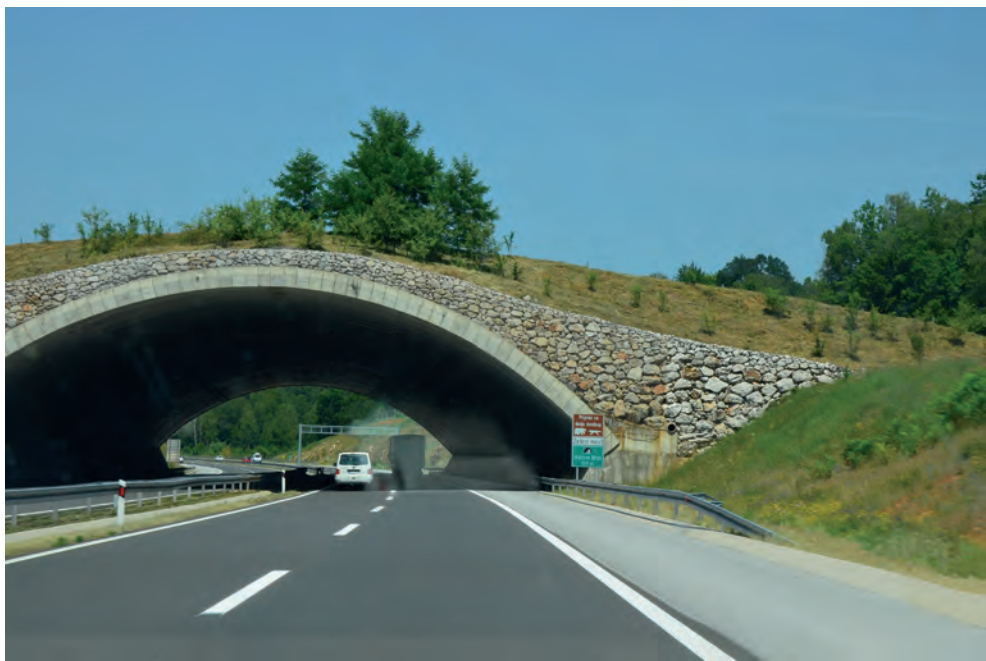
En ekodukt kan överbygga barriärer för både människor och djur. Foto: F. Bengtsson.
