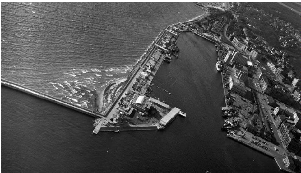
H55-utställningens byggnader under uppförande, Lindberg foto 1954
