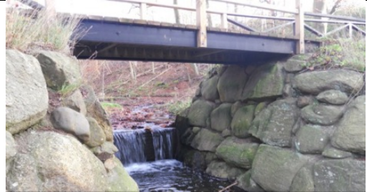
Beskrivning av påverkan: Dagvatten i ravin och lövskog med stor andel grundvattenpåverkan
