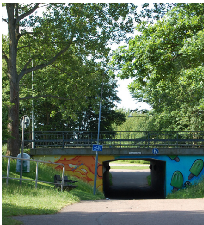
Gångtunneln under Vasatorpsvägen.
