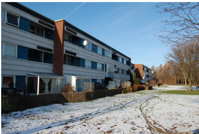
Husfasader, balkongsidan, ut mot de gröna mellanrummen.
