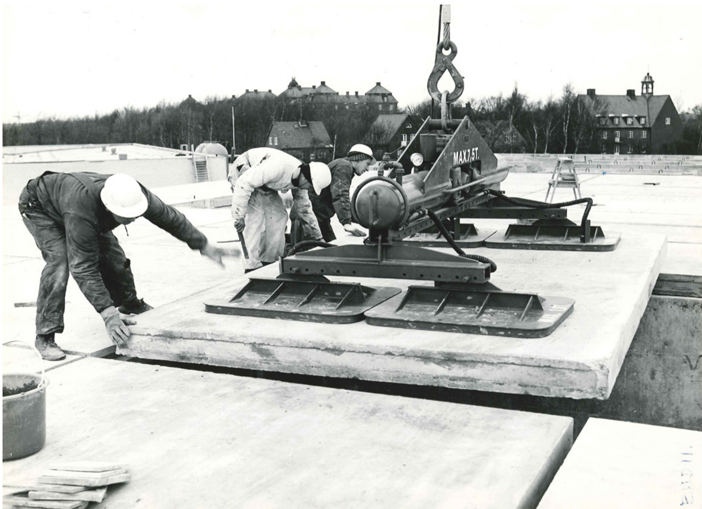
Bostadsområdet Drottninghög under byggnation. Foto: ©Kulturmagasinet/Helsingborgs museer.
