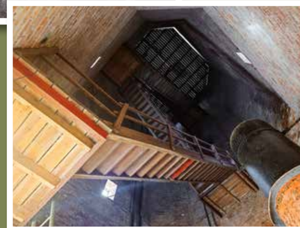
Trappan i schaktet, nerifrån.
